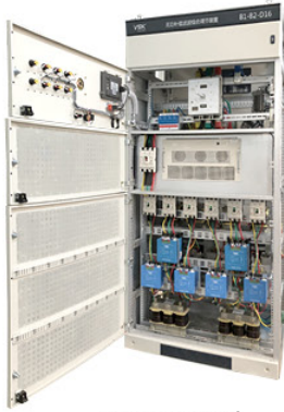
VSK-AS+D 型 (有源无源混合型补偿及滤波功能, 一体装置)
